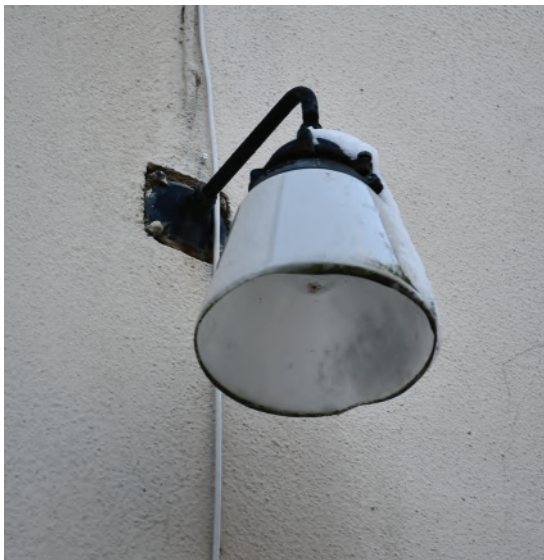
Ovan. Äldre lamparmatur av enkel funktionell typ på gaveln mot norr. Det är relativt ovanligt att denna typ av karaktärsskapande detaljer finns bevarade.
