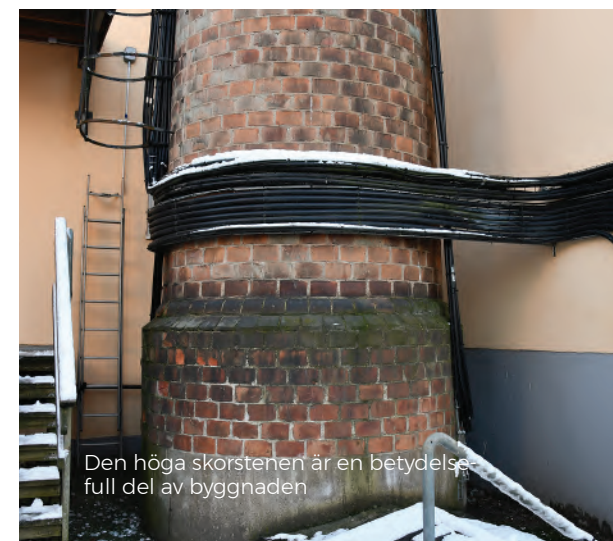
Byggnadsdel II. Bevarad fasadutformning. Flera äldre fönster och dörrar med omfattning i konststen är bevarade. I den lägre byggnadsdelen t.v. har fönstren bytts, men med bibehållet uttryck trots att de är i metall. Äldre dörrar (tidigare i mörk färg). Skärmtaket är nytt.
