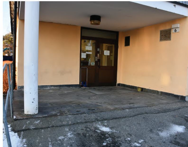
Den runda pelaren som bär upp den tillbyggda delen av övervåningen är typisk för funktionalismens byggnader. Skifferstenen som utgör markbeläggning vid entrén är också typisk för tiden. (Porten är utbytt.)
