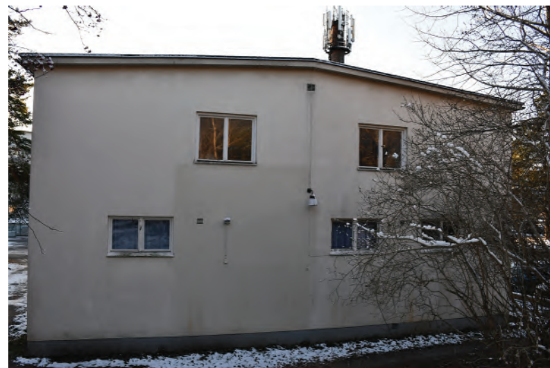
Gavelfasad mot norr. Äldre fönster bevarade, fönstersättning bevarad förutom att ett fönster är igensatt. Det flacka taket är ett typiskt uttryck för funktionalismens byggnader.
